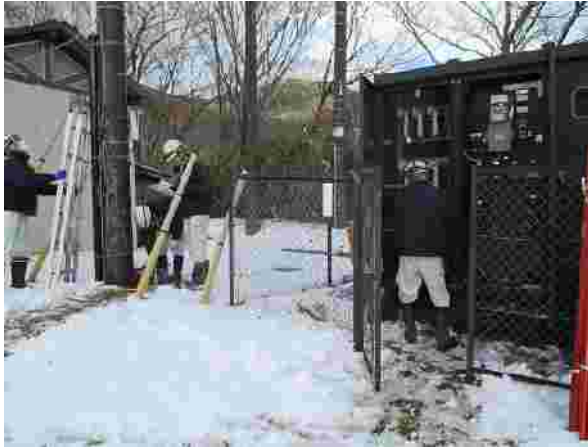
【電気設備点検 (H30.12.12)】
