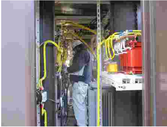
【電気設備点検 (H29.12.4)】
