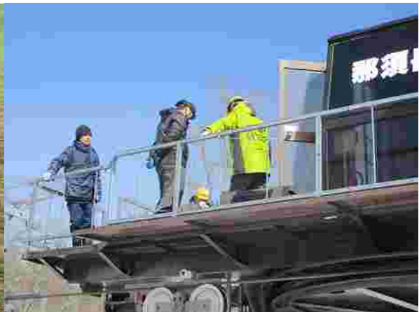
【メーカー定期点検 (R1.12.28)】
