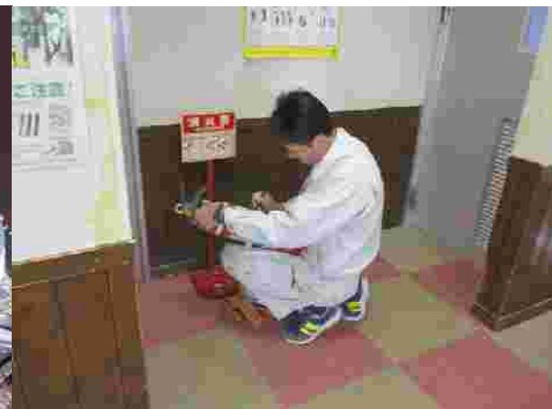
【消防設備点検(R1.12.11)】
